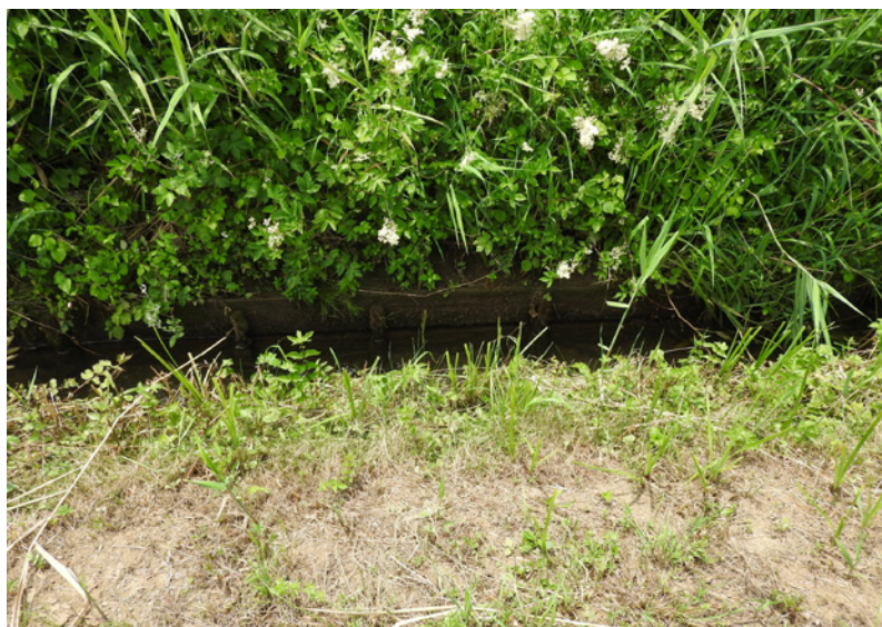
Böschungsbretter am Erlösenbach (05.07.2016)
